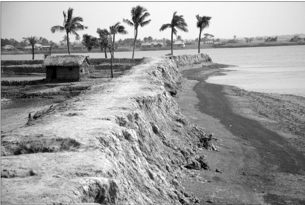
Fotografija 4: Protipoplavni nasip v vasi Chuibarua v občini Padma Pukur je zaradi Aile popustil in voda iz rečnega rokava (desno) je zalila koče na poplavni ravnici (levo). Območje v ozadju, ki je danes pod vodo, je bilo pred katastrofo riževo polje (avtor: Jurij Kočar).
