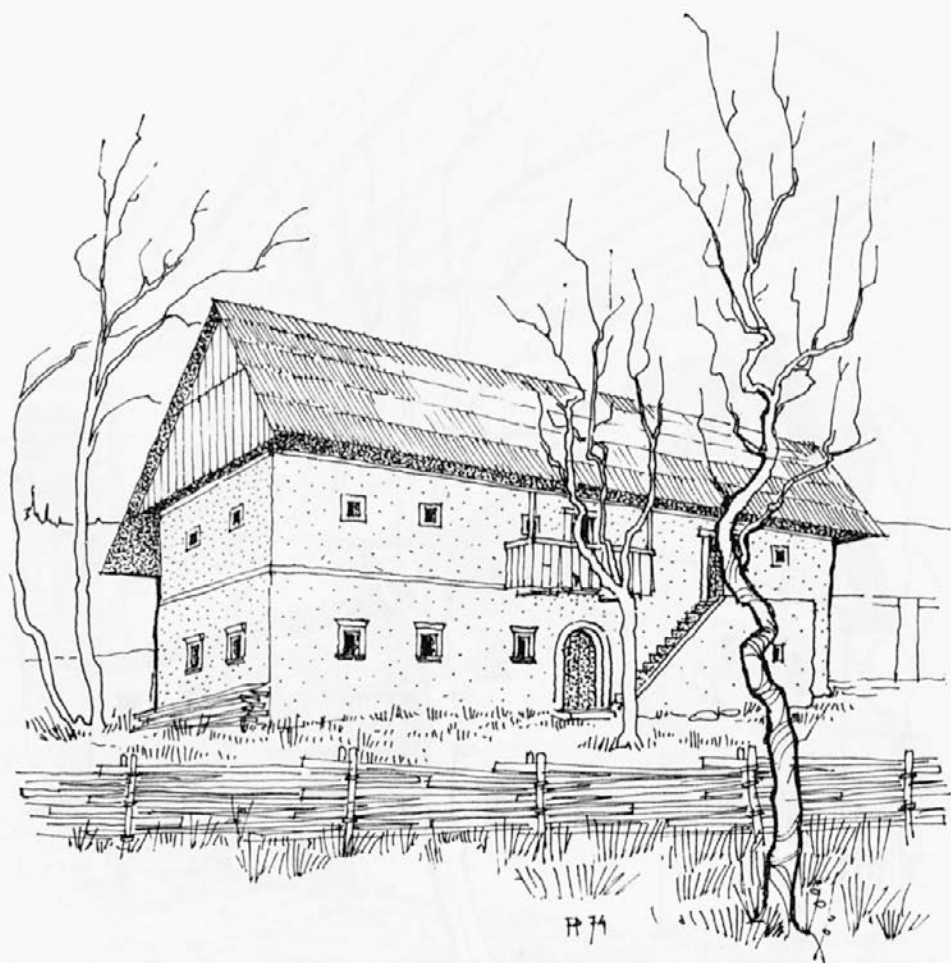
Vertikalna »prehodna« stanovanjska stavba (Možjanca 8). Zunanje stopnišče in vhod v kaščo sta bila dodana šele konec 19. stoletja. Posebnost je ista širina stanovanjskega in shrambnega dela.
