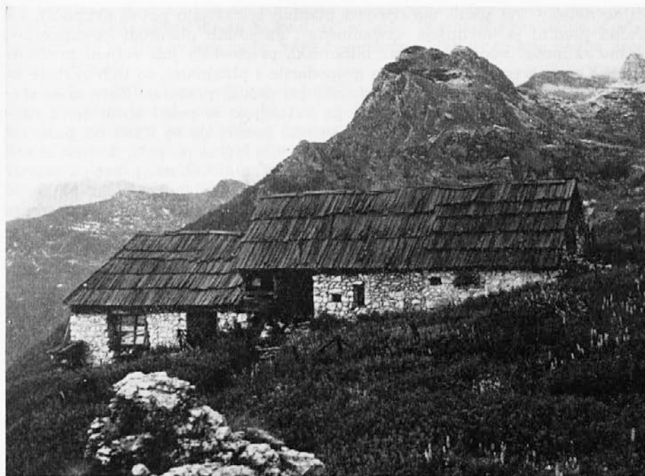
Slika 8. Naselje na ovčji planini Za črnim vrhom (1513 m). Pred nekaj leti je plaz močno poškodoval planinske stavbe (foto: N. Križnar, 1973)
