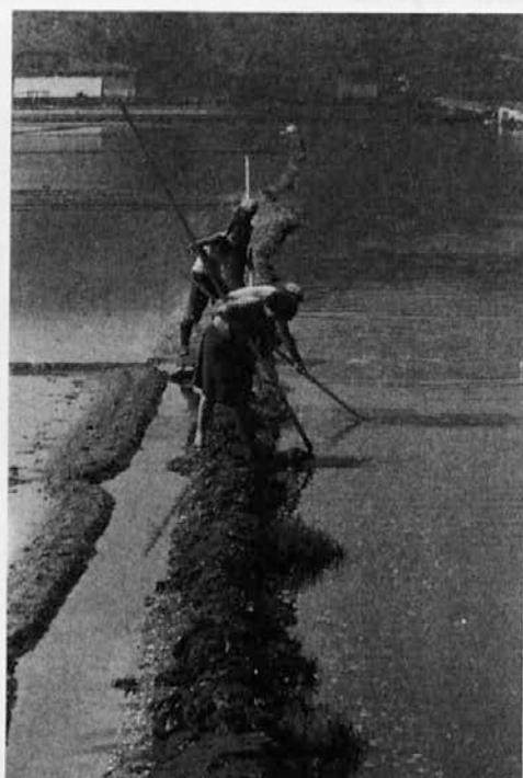
Vzdrževalna dela na nasipu v solnem polju. Soline Fontanigge. Foto: Josip Rošival, 1961
