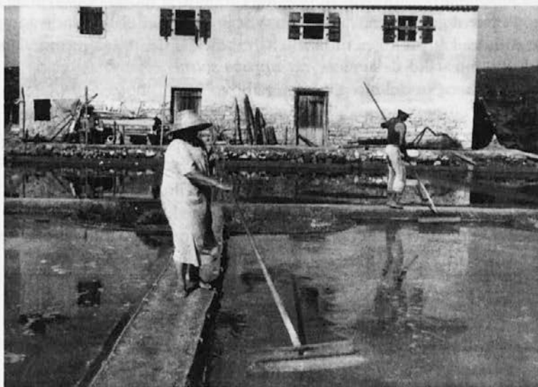
Solinarka in solinar grabita sol v kristalizacijskem bazenu. Soline Fontanigge.
