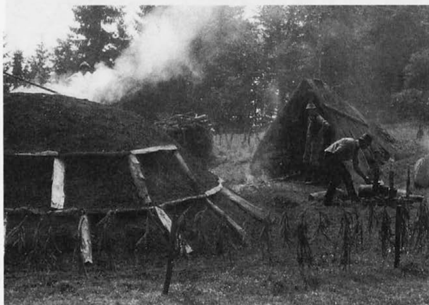
Če prst drsi, je treba dodati še eno vrsto -polic- ; desno je en kopar v koparski bajti, drugi pa pri ognjišču
