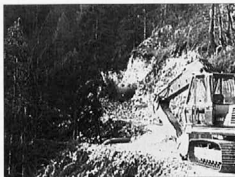
Gradnja gorske ceste.
