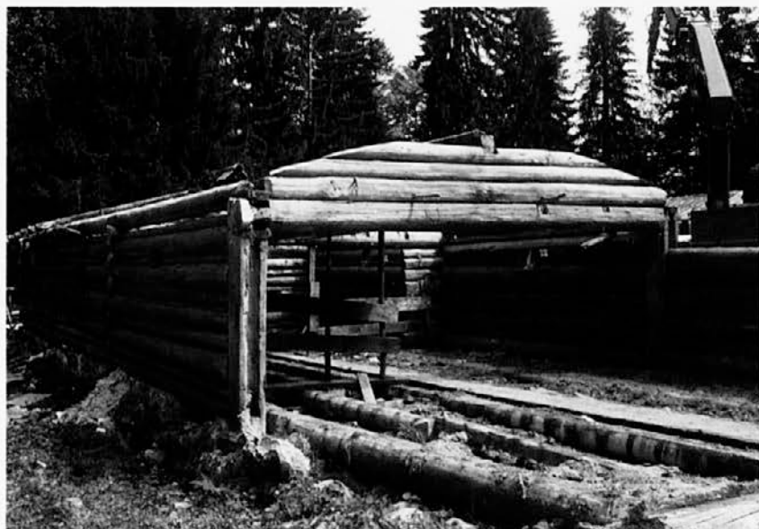
Abb. 4: 1895 wurde der Stall um die Hälfte verlängert. An den ehemaligen Blockbauecken stehen jetzt Spundpfosten zur Aufnahme der anschließenden Wandbalken
