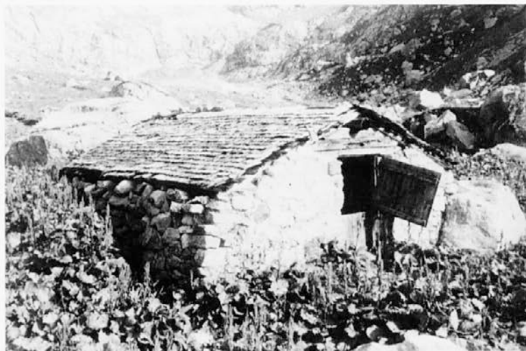
Abb. 1: Einräumige Sennhütte am Sustenpass (UR), erbaut im 20. Jh., in der Anlage und Bauweise jedoch spätmittelalterlich (Bild B. Furrer, 1986)
