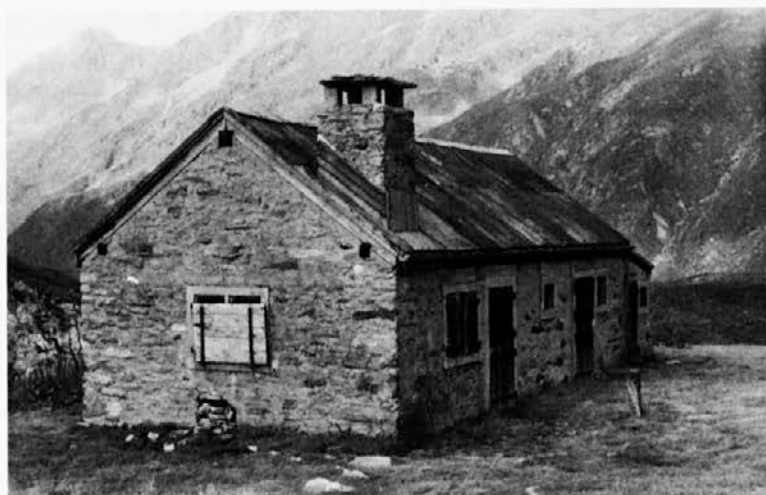
Abb. 4: Sennhütte mit Stall für krankes Vieh. Subventionierter Bau von 1929. Andermatt, Unteralp (Bild B. Furrer 1982)
