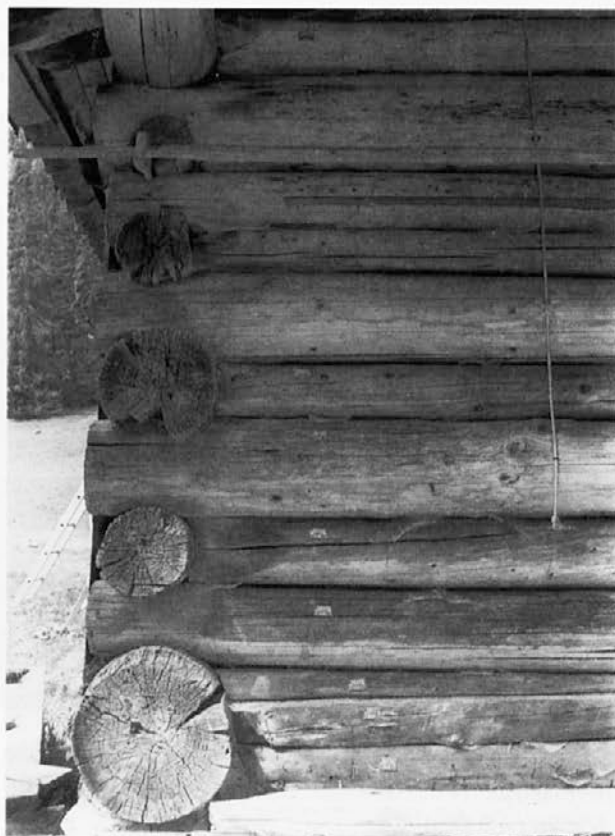
Abb. 2: Detail der Blockwandkonstruktion
