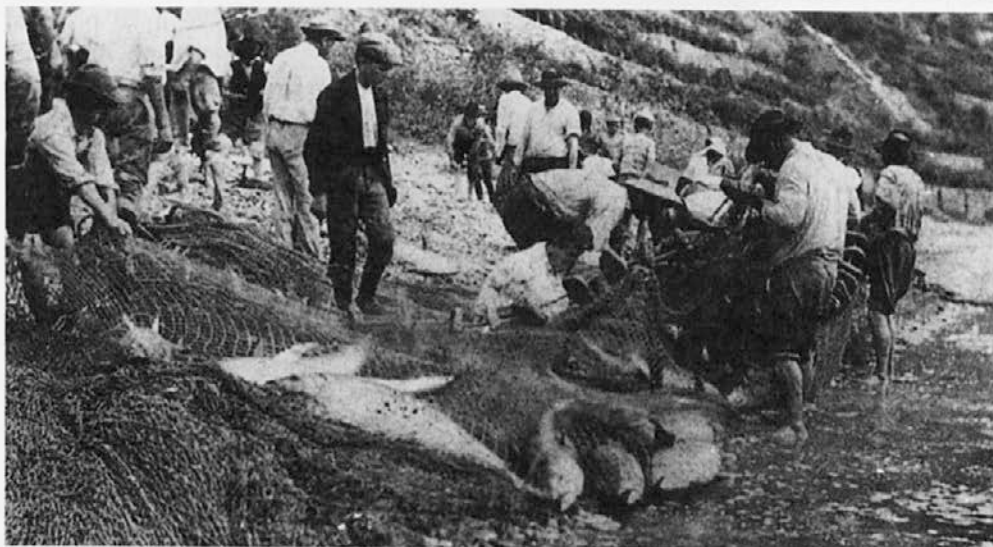
Najstarejši posnetek tonolova pred 1. svetovno vojno. Ribiči imajo dolge spodnje hlače zavahane do kolen
