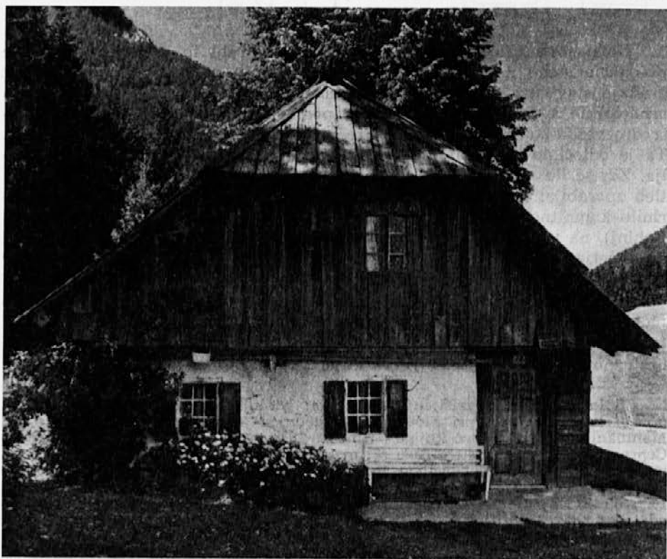
Sl. 17: Značilna pritlična kmečka hiša s podolžno vežo (nem. Längslaubenhaus) v Selah v Rožu (prim. tloris I, sl. 14). Foto: E. Primožič.
