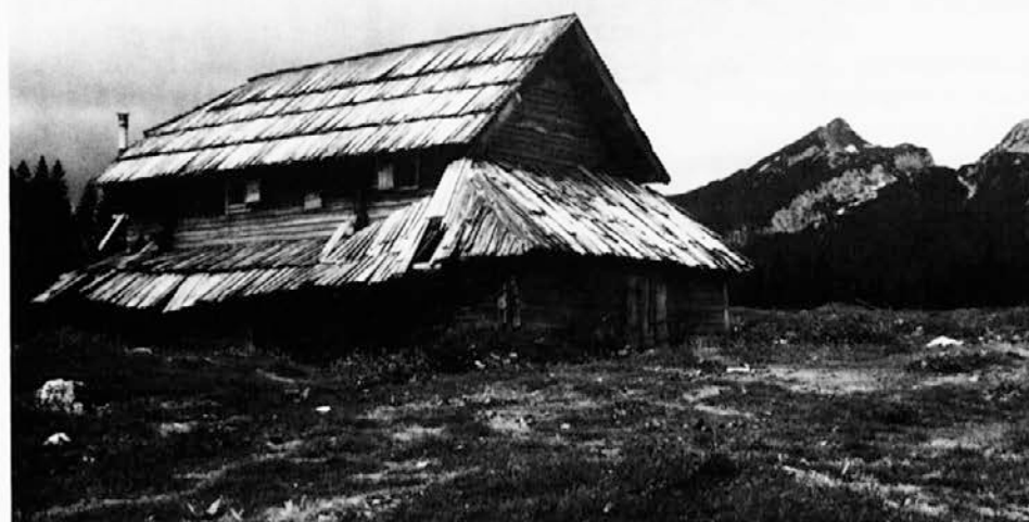
12 Nadstropni stan s hlevi ob podolžnih stenah in zadnji čelni steni, planina Javornik (1300m), /Stockhütte mit Ställen an der Längsseiten und an der Stirnseite, Alm Javornik/ T. Cevc, 1982
