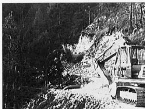
Gradnja gorske ceste.
