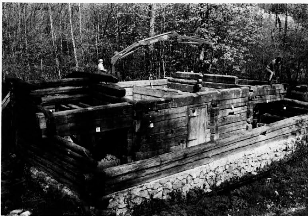
Abb. 13: Beim Abbau (Aufnahme 1993) wird das Baugefüge deutlich ablesbar: das in kräftigem Kantholzblockbau gezimmerte Innere ist ringsum vom Stall mit Rundholzblockwänden umgeben. Die Abschrägung der (wohl als auskragend geplanten) Konsolbalken, links sichtbar, weist darauf hin, daß der Kaser auf der Eingangsgiebelseite ursprünglich offen geplant war
