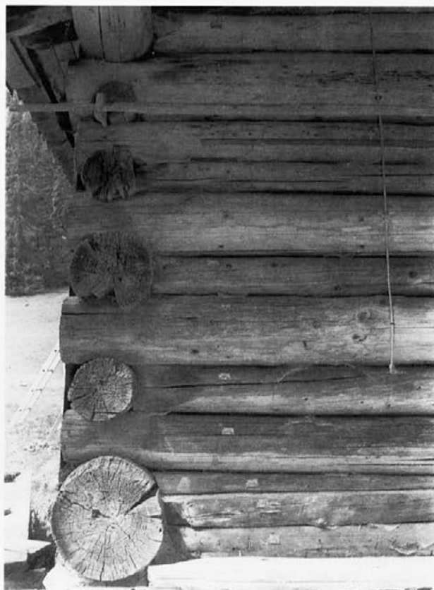
Abb. 2: Detail der Blockwandkonstruktion
