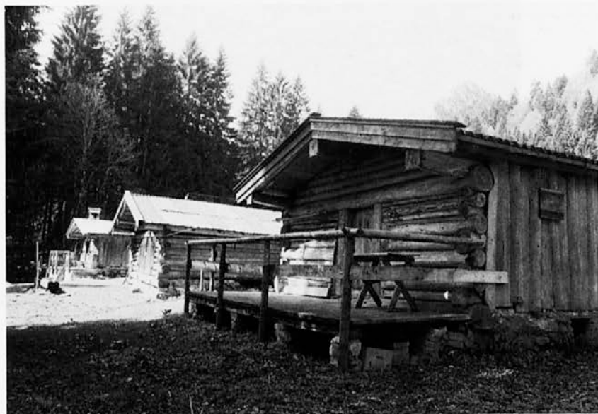
Abb. 1: Duslau-Alm bei Kreuth/MB, Aufnahme 1992, mit den beiden Almgebäuden und dem gemeinsam benutzten Heustadel dazwischen. Das Gebäude im Vordergrund wird zur Zeit an der Glentleiten wiederaufgebaut
