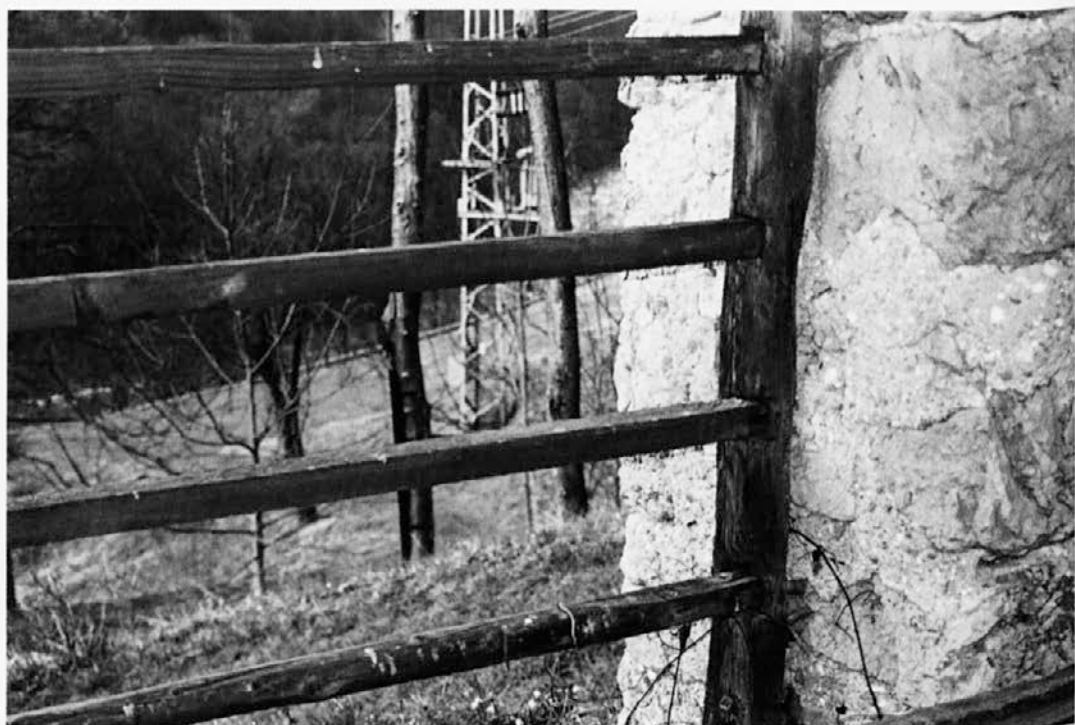
Sl. 13: Detajl lesene opore z latami v zidanem stebru kozolca, Stopnik 6 (foto: T. Cevc, 2001)
