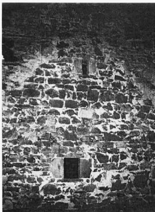
Sl. 3: Zgornji del vzhodnega pročelja, danes pod streho vzhodnega prizidka. Spodaj je okno, zgoraj dimna lina; dobro je viden stik nadzidave in prvotnega zatrepa. – Foto Božidar Premrl.
