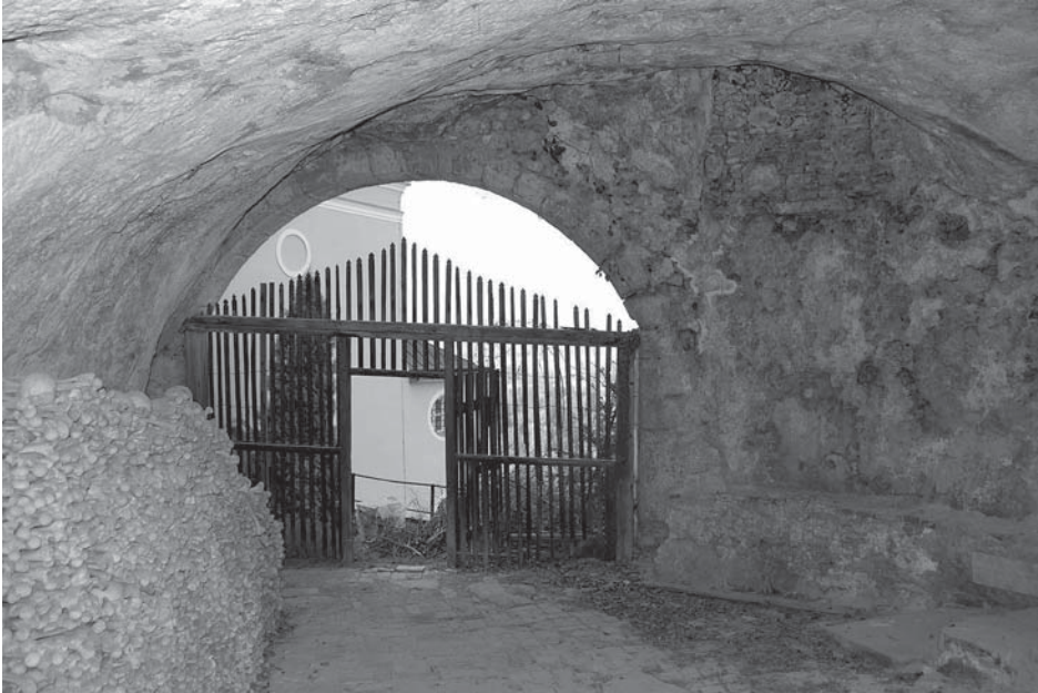
Bild 12: Das Portal von innen. Rechts oben ein vermaueretes Naturfenster.
