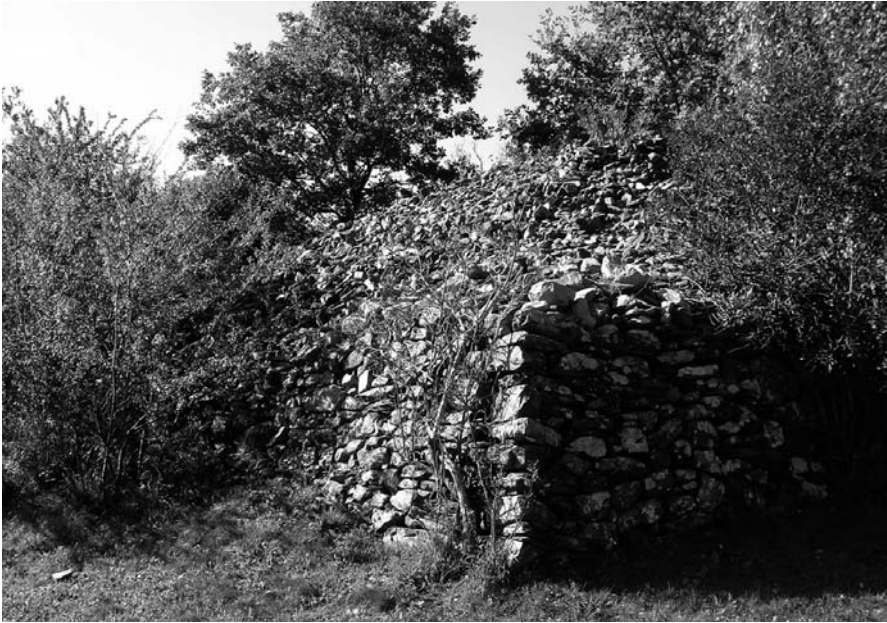
Eine Gröfel am Rande eines Feldes im Gemeindegebiet von Gaimberg (Osttirol). Deutlich zu erkennen ist, wie der Steinhaufen am Rande aufgemauert wurde (Foto: Bergmann 2006).
