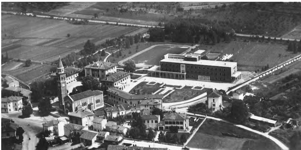
Posest Inštituta Maddalena v Šempetru pri Gorici pred drugo svetovno vojno, na katerem se je prezidala obstoječa stavba in sezidala nova bolnišnica dr. Franca Derganca (1949–1975).
