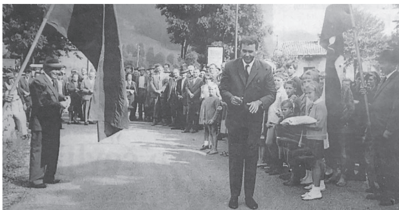
Lokve, avgust 1967, tedanji predsednik Skupščine Občine Nova Gorica Jožko Štrukelj, ob odprtju še zadnjega, 8-kilometrskega dela asfaltirane ceste Trnovo–Lokve (arhiv društva LO-KO).
