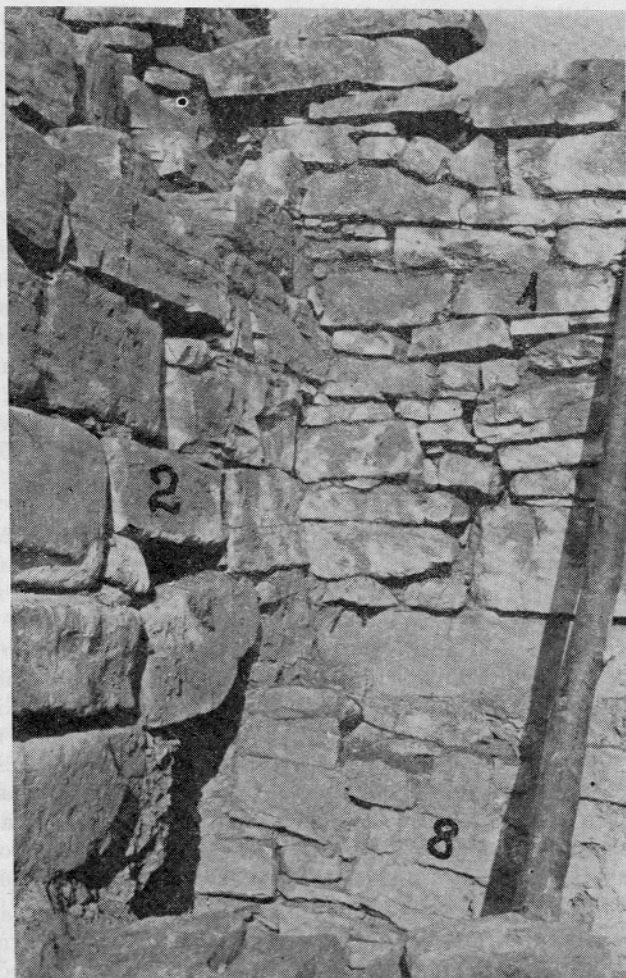
Sl. 5. Podporni zid 2, spojen s pravokotno nanj postavljenim zidom 1.
