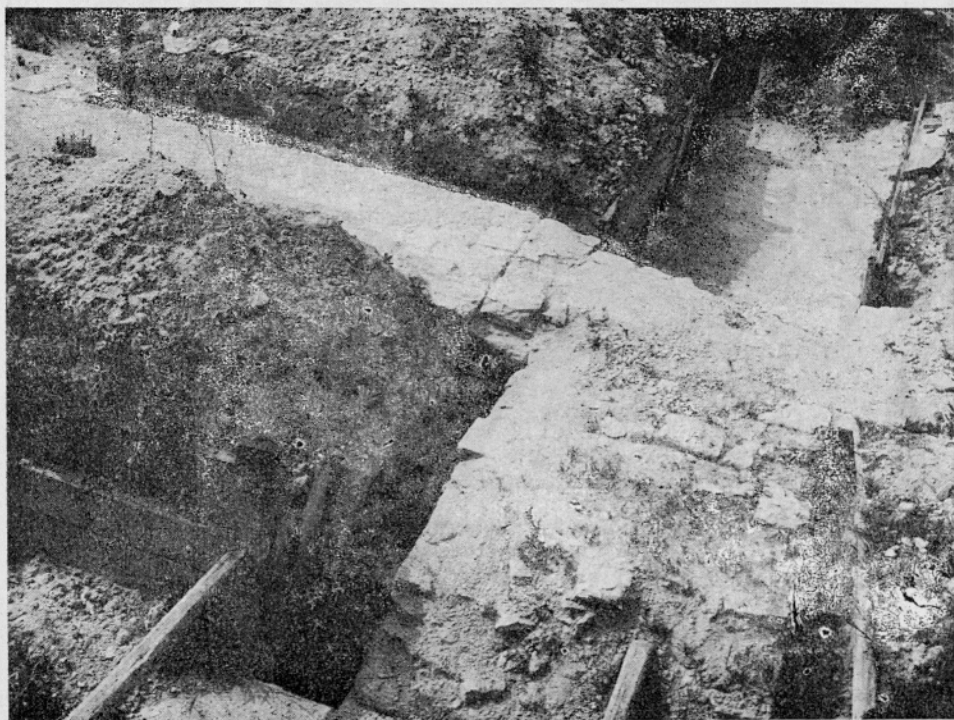
Fig. 7. Classe (Ravenna). Chiesa alla Cà Bianca: la fondazione frontale cui si legano le strutture del quadriportico
