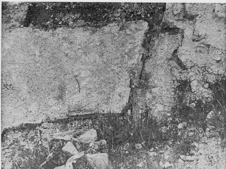
Fig. 12. Classe (Ravenna). Giustapposizione del muro trasverso dell'absidiola »coxata« allo sperone angolare sud della chiesa
