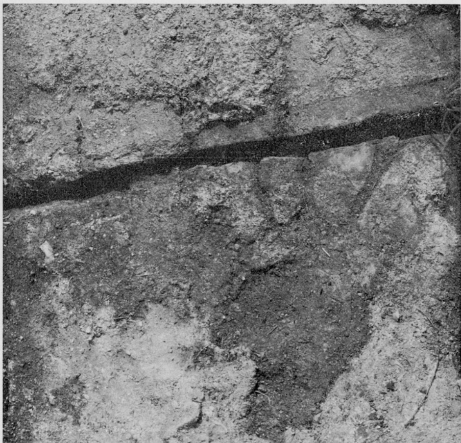
Fig. 9. Classe (Ravenna). Giustapposizione della fondazione del deambulatorio sud alla struttura del quadriportico
