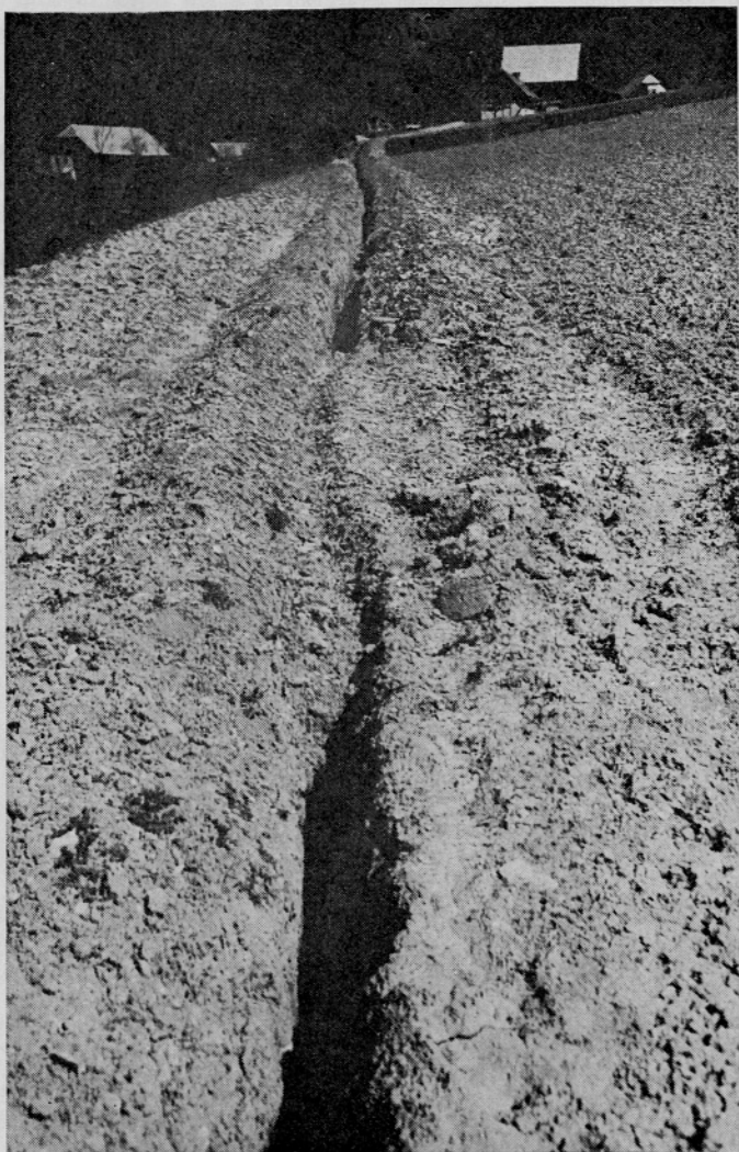
Sl. 2a. Veliki Kamen, jarek za vodovod Fig. 2a. Veliki Kamen, the ditch for the waterworks
