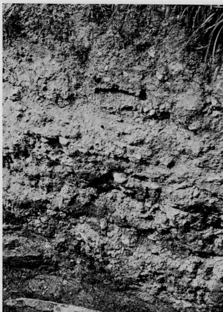
4 Gramoz cestišča rimske ceste v profilu št. 15. — Schotter des römischen Strassenkörpers im Profilgraben Nr. 15.
