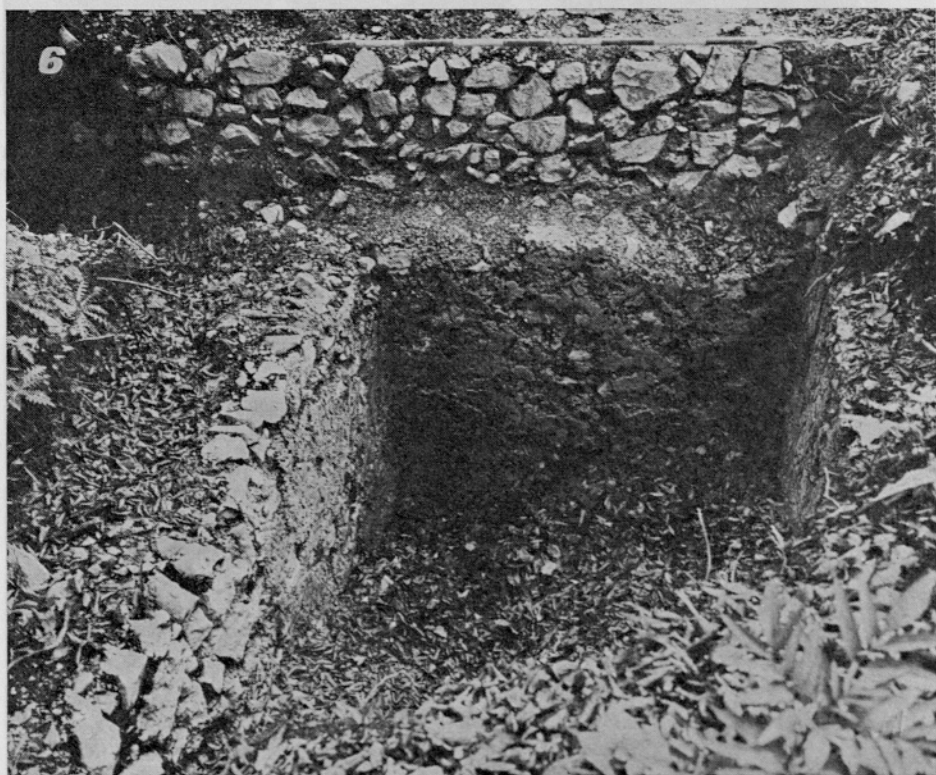
6 Deloma odkopan vodni zbiralnik v objektu XIV. — Teilweise ausgegrabener Wasserspeicher im Objekt XIV.
