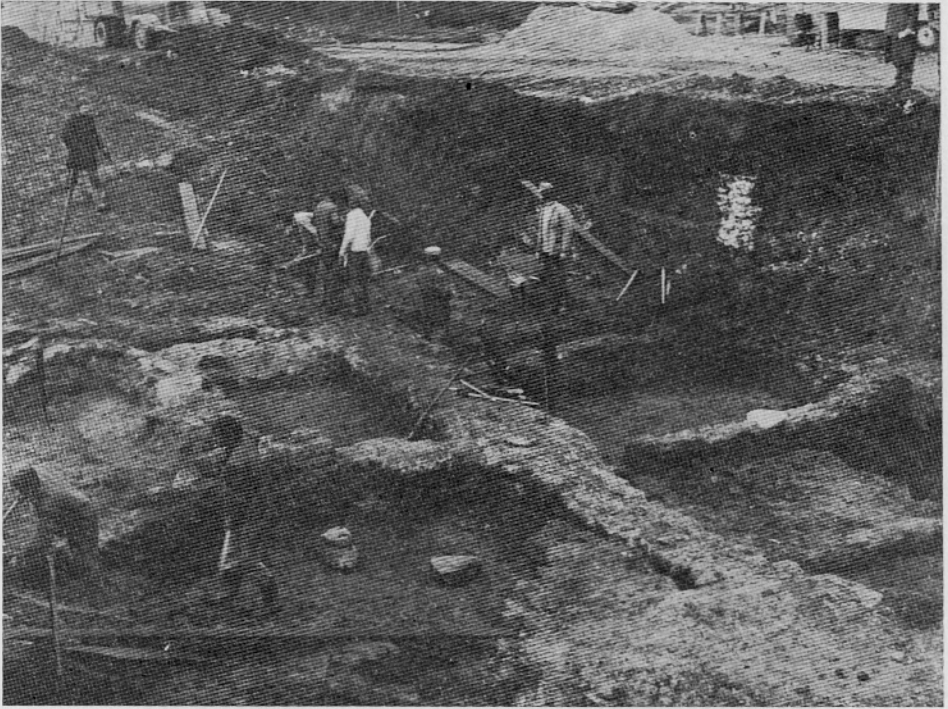
Sl. 7: Ptuj, Vičava 1975, pogled na severovzhodni del izkopa z ohranjenimi temelji rimskega objekta.
