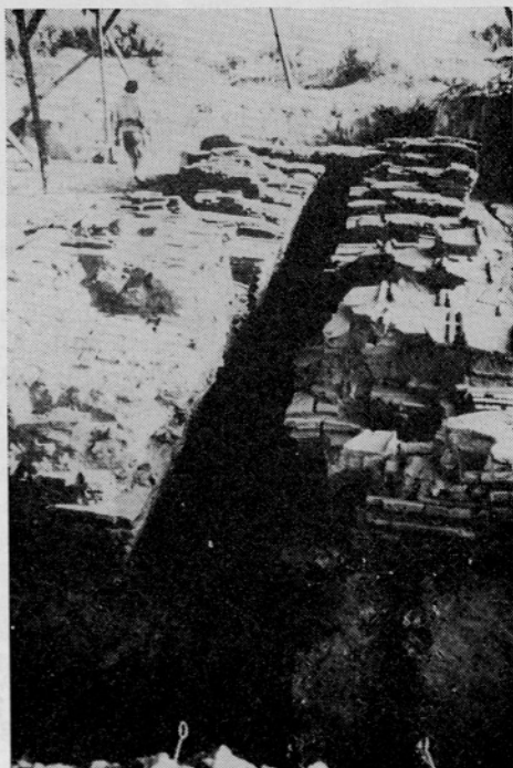
Abb. 2: Ziegelbrennofen 1 von N.
