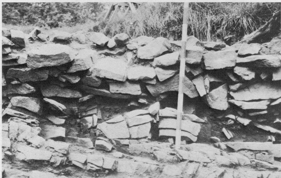
T. 22: Rodnik — Grobišče Pod Jezerom. 1. Grob 11, poševna kamnita plošča nad njim in rob poti; 2. fronta suhega zidu, ki je podpiral nasutje poti.
