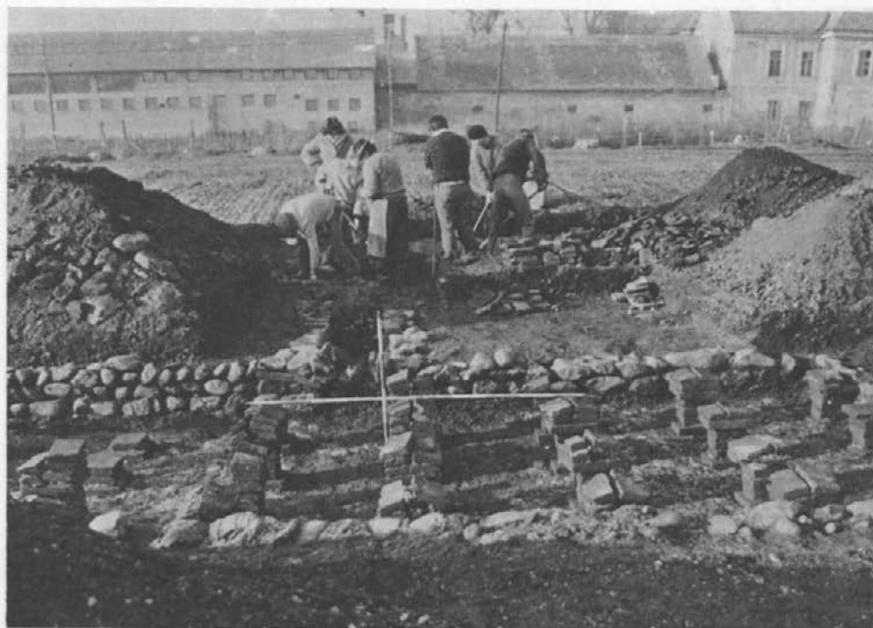
Sl. 4: Betnava. Villa rustica , Pogled na del stanovanjske stavbe s hipokavstom. Abb. 4: Betnava. Villa rustica . Blick auf den Teil des Wohngebäudes mit dem Hypokaustum.
