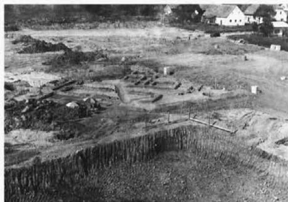
Sl. 2: Ptuj, Rabelčja vas - zahod. Pogled na ostanke rimske lončarske delavnice ob arheoloških zaščitnih delih na B-1 in B-2 leta 1981 (foto: Ivan Tušek).
