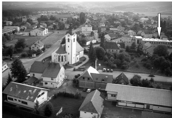
Sl. 1: Spodnje Hoče, pogled z vzhoda. Župnijska cerkev sv. Jurija in območje arheoloških raziskav leta 1997 (puščica označuje stavbo podjetja Orglarska delavnica Maribor). Fig. 1: Spodnje Hoče, view from the east. St. George's Parish Church and the area of archaeological investigations in 1997 (the arrow indicates the building of the workshop "Orglarska delavnica Maribor").
