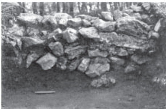
Sl. 8: Šumenje pri Podturnu. Sonda 1: zunanje lice zidu s štirimi legami kamnov.
