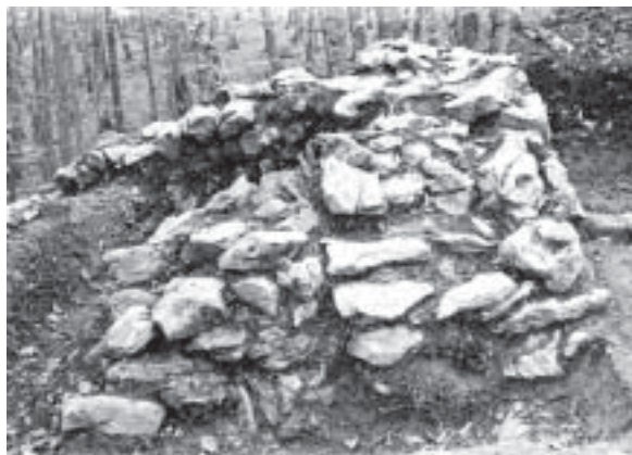
Sl. 14: Šumenje pri Podturnu. Sonda 2: podpornik na zunanji strani prečnega zidu; pogled z zahoda.
