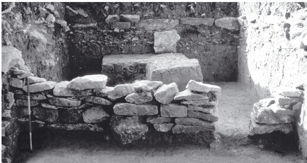
Sl. 16: Veliki Vinji vrh. Podporni zid s severne strani. Abb. 16: Veliki Vinji vrh. Stützmauer von Norden.
