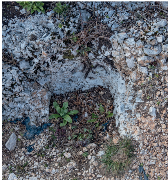
Sl. 6: Sv. Pavel nad Vrtovinom. Vdolbina za leseni tram v zahodnem delu severovzhodnega vhoda.
