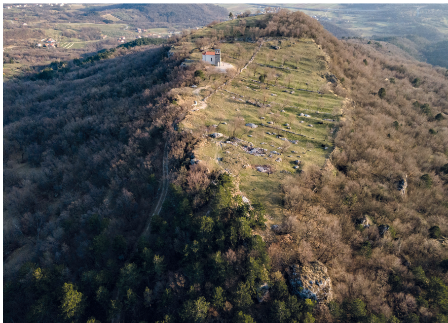
Sl. 3: Sv. Pavel nad Vrtovinom. Severni del platoja s cerkvijo Sv. Pavla in z dobro vidnimi naselbinskimi terasami. Pogled s severa.
