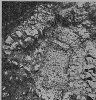
Notranjost kanala na točki 3
