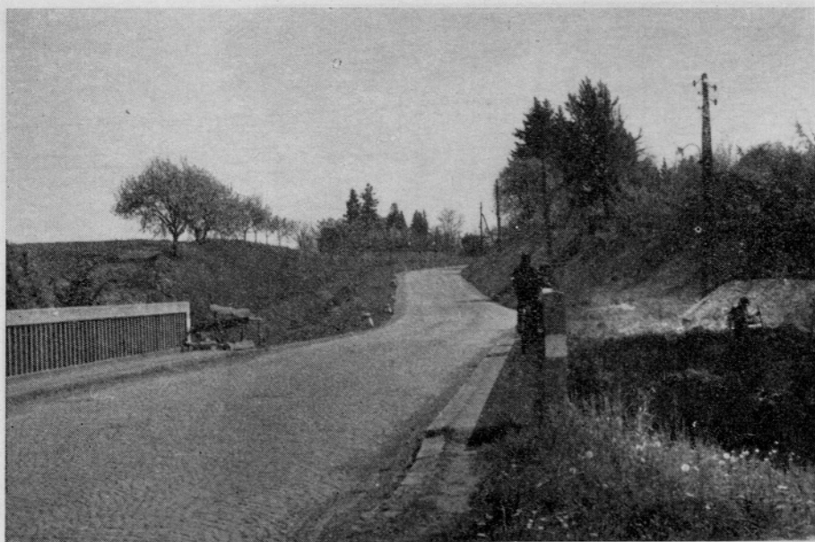
Sl. 7. Pogled na antični in sedanji cestni usek med mostom preko Lešnice in Ormožem (od Z)
