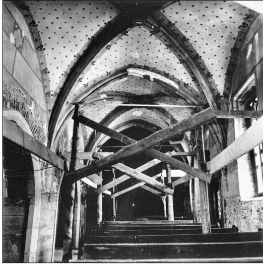
21. Slovenske Konjice, župnijska cerkev sv. Jurija, severna kapela, arkadni loki med obnovitvenimi deli v sedemdesetih letih 20. stoletja (© INDOK center MK)
