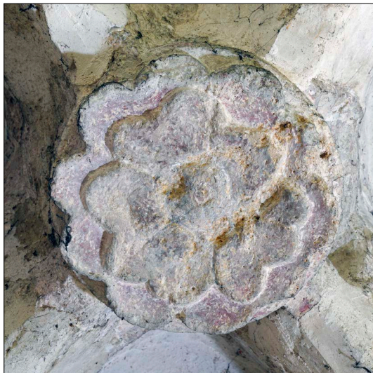
23. Slovenske Konjice, župnijska cerkev sv. Jurija, severna kapela, sklepnik v zahodni traveji (© ZRC SAZU, foto: Andrej Furlan)
