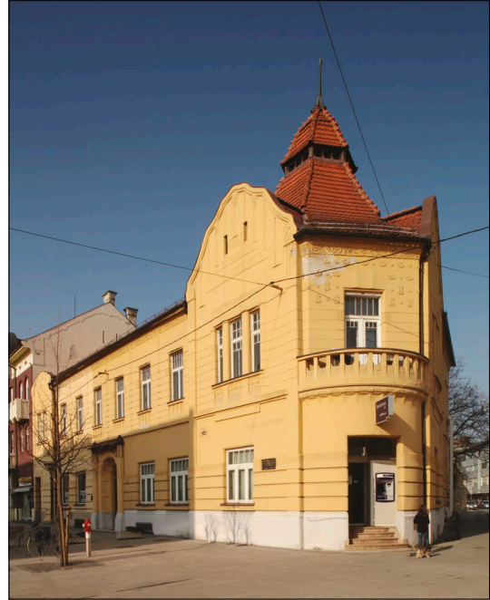
13. László Takáts: Sparkasse des südlichen Teils von Komitat Eisenburg (jetzt Haus der Kulinarik), Murska Sobota, 1907
