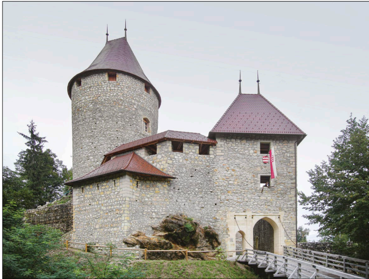
1. Burg Sannegg, heutiger Zustand
