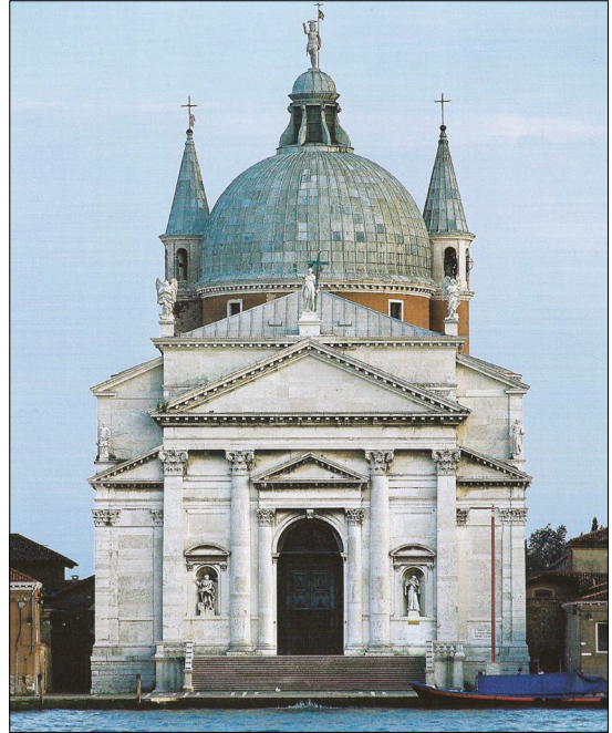
6. Andrea Palladio: Il Redentore, Venedig, Fassade
