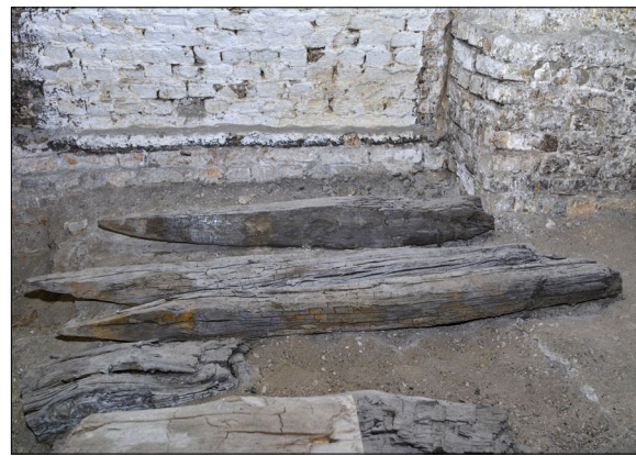
15. Posen, ehemalige Jesuitenkirche, Eichenpfähle aus dem vierten Joch des Mittelschiffes
