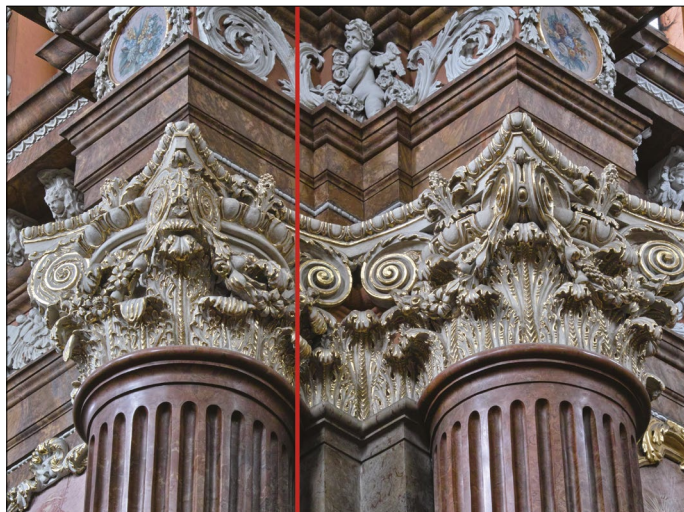
21. Posen, ehemalige Jesuitenkirche, Säulenkapitelle aus der nordöstlichen Kreuzungsecke mit der Grenze zwischen den Bauphasen unter Wąsowski und Catenazzi
