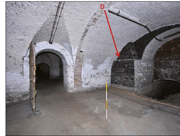
18. Posen, ehemalige Jesuitenkirche, Keller unter dem ersten Joch des Chores in Richtung Nordost (D – gebundene Eckpfeiler und Säulenunterbau)
