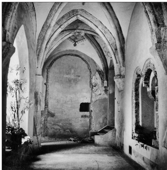
18. Obris prvotnega meniškega vhoda iz križnega hodnika v cerkev ob odkritju, cistercijski samostan Stična
