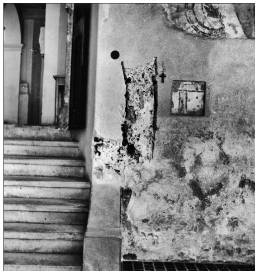
19. Ostenje niše ob vhodu iz križnega hodnika v cerkev ob odkritju, cistercijski samostan Stična
