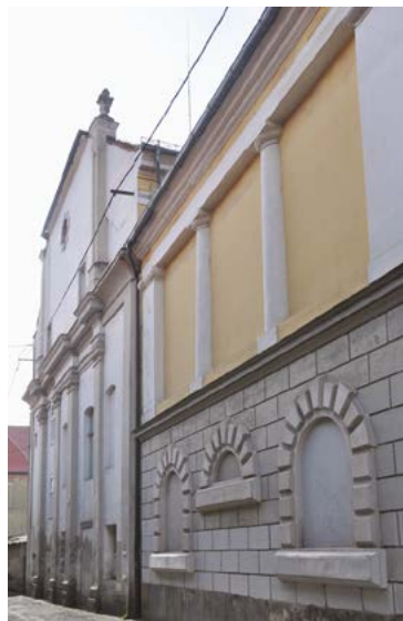
12. Vzhodno pročelje povezovalnega trakta med nekdanjo celestinsko cerkvijo in tovarno kavnih nadomestkov ter stanovanjsko hišo (© ZRC SAZU, UIFS; foto: Andrej Furlan)
