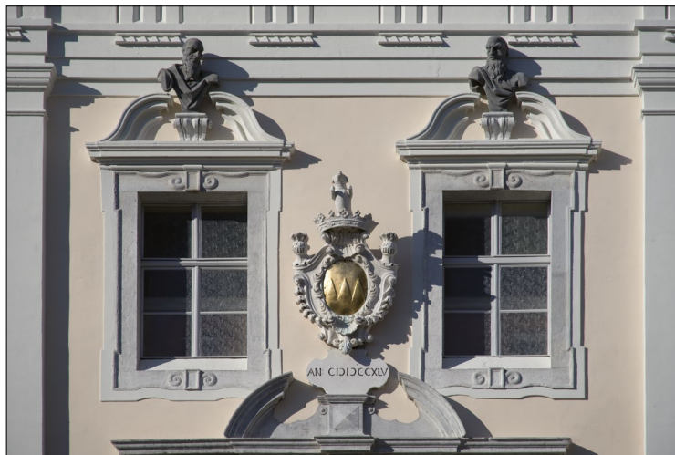
2. Grb na fasadi, 1745, palača Attems Petzenstein, Gorica
