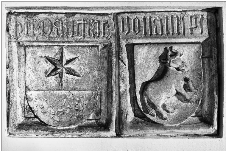
13. Plošči z grbovnima ščitkoma Auerspergov in Frankopanov ter imenom Pankraca Auersperga, konec 15. stoletja, transept cerkve cistercijskega samostana Stična
