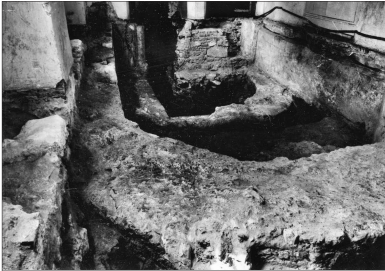
8. Temelji romanskega in gotsko prezidanega vzhodnega zaključka kapele sv. Jurija ob odkritju, cerkev cistercijskega samostana Stična
