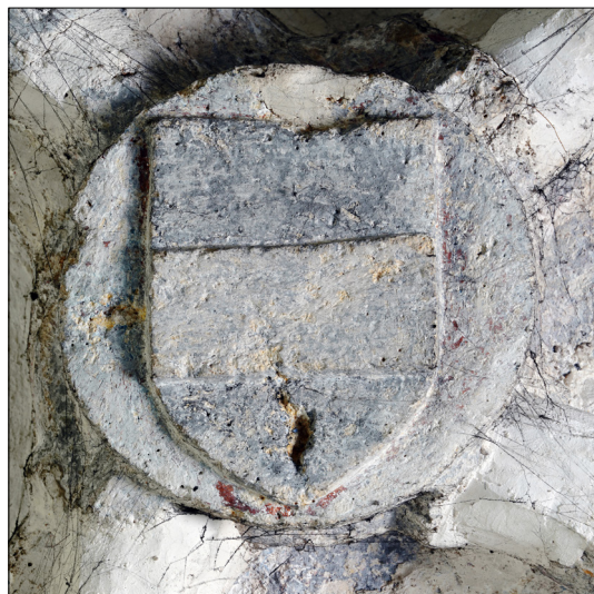
25. Slovenske Konjice, župnijska cerkev sv. Jurija, severna kapela, sklepnik z grbom rodbine Wallsee (© ZRC SAZU, foto: Andrej Furlan)
