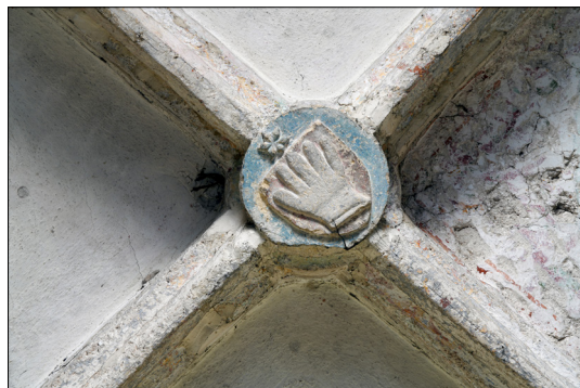
28. Slovenske Konjice, župnijska cerkev sv. Jurija, severna kapela, stik sklepnika z rebri v vzhodni traveji (© ZRC SAZU, foto: Andrej Furlan)
