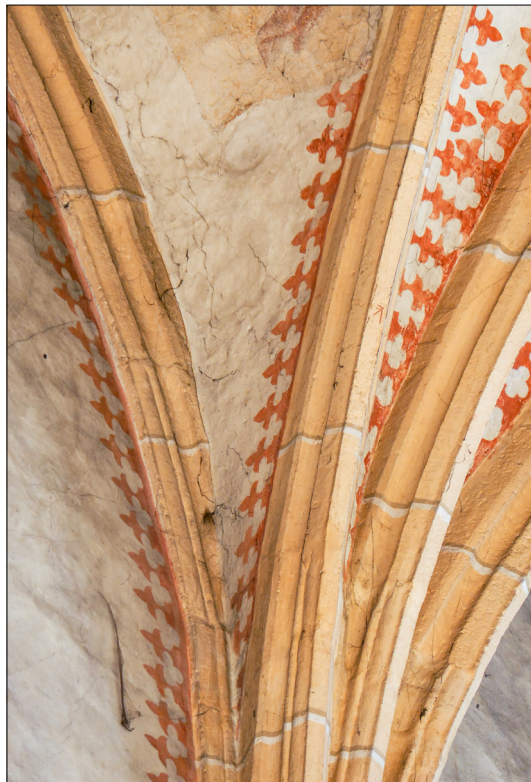
42. Celje, župnijska cerkev sv. Danijela, kapela Žalostne Matere božje, sprememba v profilaciji reber (© ZRC SAZU, foto: Gorazd Bence)
