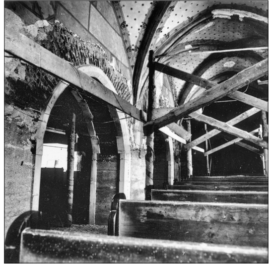
22. Slovenske Konjice, župnijska cerkev sv. Jurija, severna kapela, pogled na arkadne loke med obnovitvenimi deli v sedemdesetih letih 20. stoletja (© INDOK center MK)
